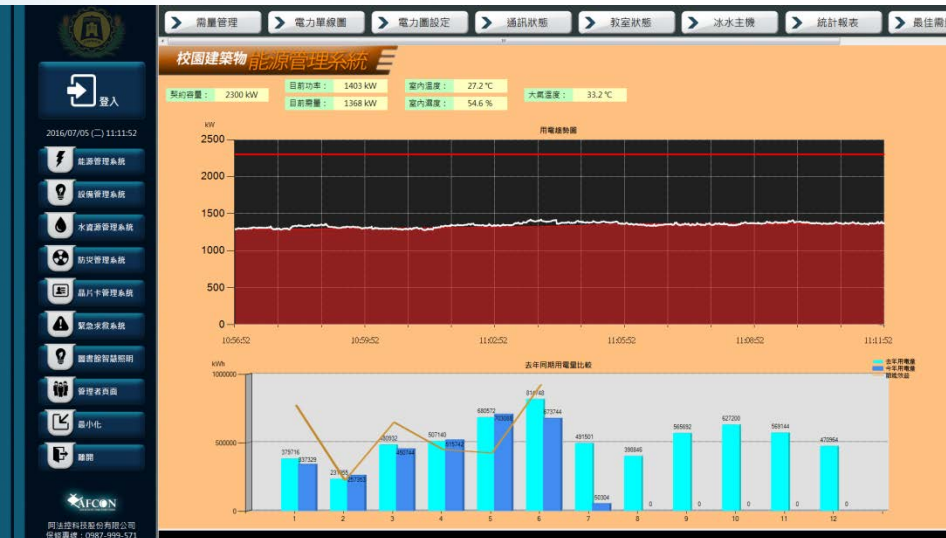
⌚ 電力監控系統
