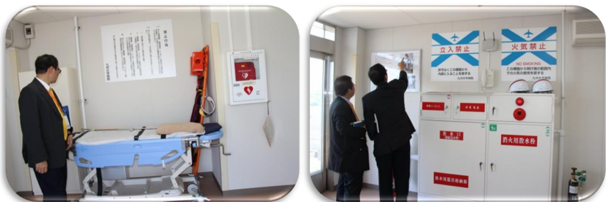
圖 23：直升機停機坪週邊設施
